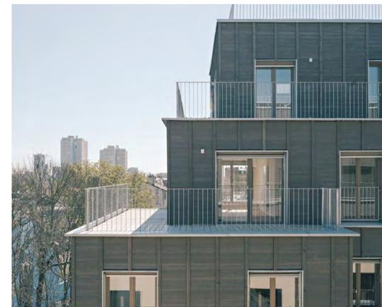
Le bois en bardage de façade exprime la rationalisation de la construction bois du projet (MOB, FOB, planchers, parquets, isolant acoustique), Logements - LA architectures, Paris (fr)
