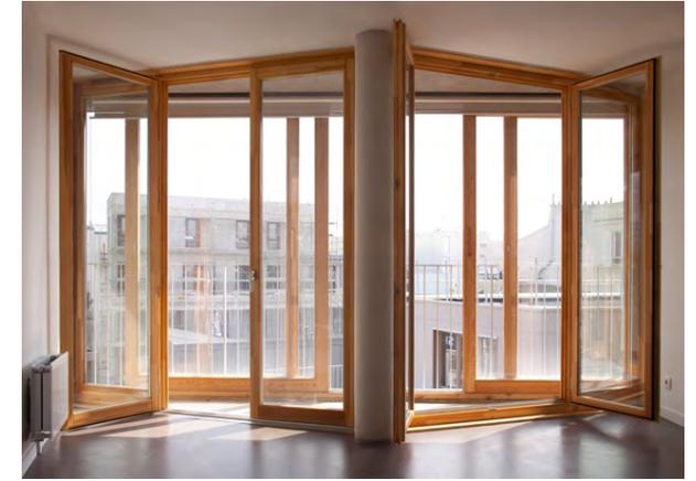
Double fenêtre avec effet mur capteur - Logements sociaux
