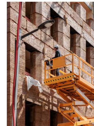
Construction en blocs de pisé préfab.
