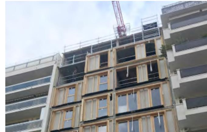
FOB et remplissage en béton de chanvre
