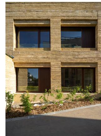
Béton recyclé damé à sec
