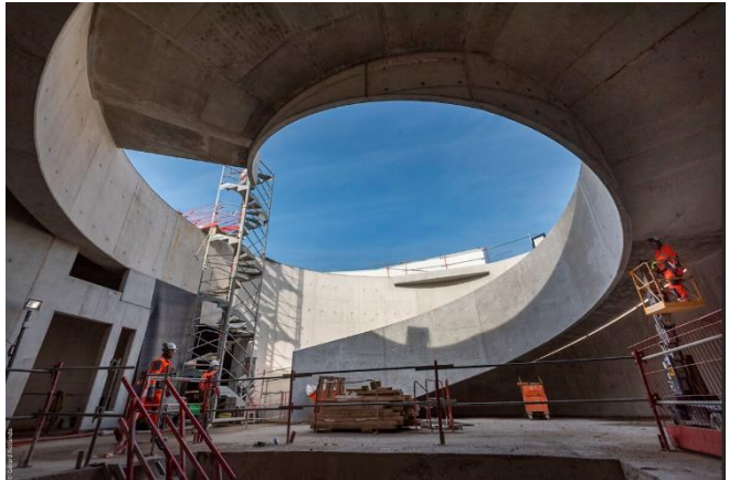
© Architecte atelier Novembre / Gérard Rollando / Société des grands projets
