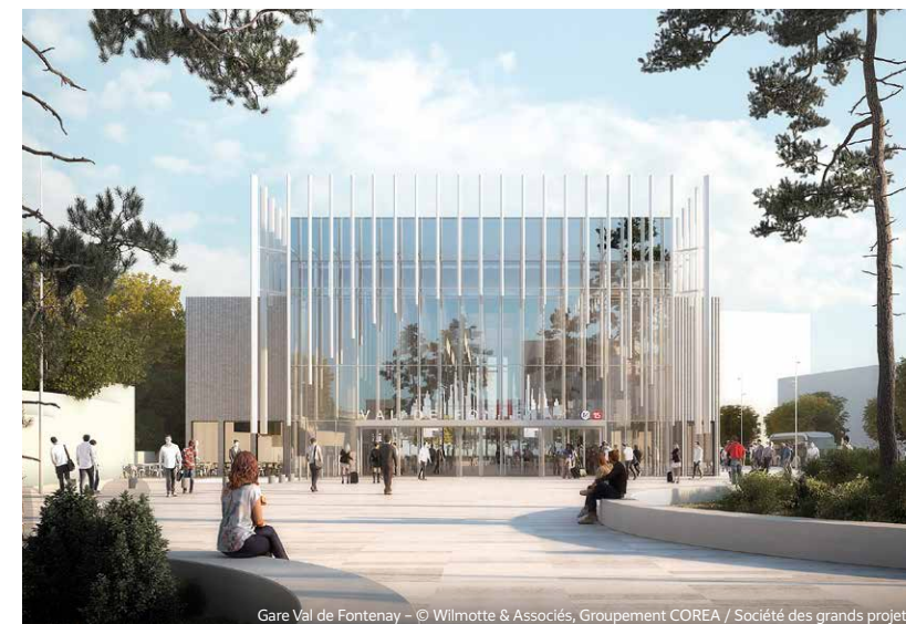
Gare Val de Fontenay - © Wilmotte & Associés, Groupement COREA / Société des grands projets
