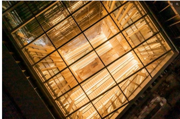
Le puits de lumière de l'atrium. © Kengo Kuma & Associates / Sylvain Cambon / Société des grands projets
