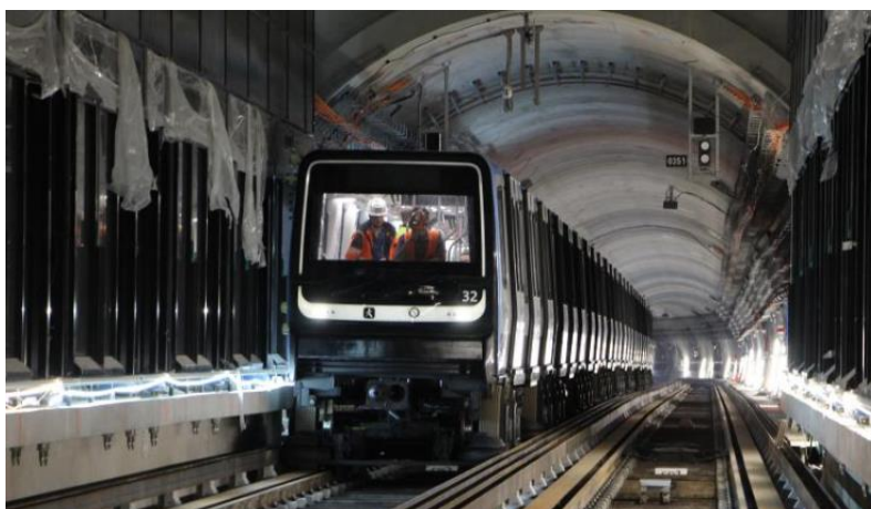
Essais d'un train sur les rails de la ligne 14 prolongée. © ALSTOM
