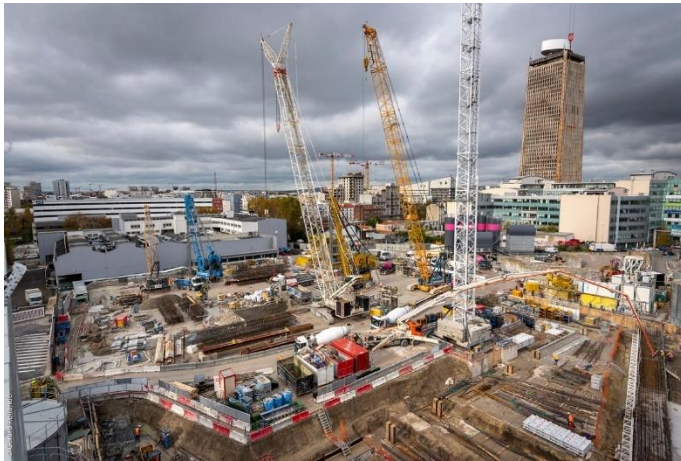
Les travaux de réalisation des parois moulées, ici en novembre 2019. © Société des grands projets / Gérard Rollando
