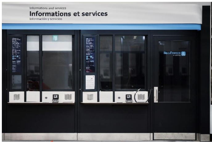
Point d'accueil en cours de pose sur la gare Aéroport d'Orly ©Groupe ADP / Lucille Pellerin / Société des grands projets
