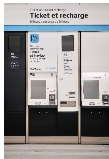
Distributeur automatique de vente en cours de pose sur la gare Aéroport d'Orly ©Groupe ADP / Lucille Pellerin / Société des grands projets
