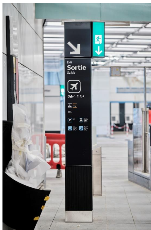
Signalétique en cours d'installation sur la gare Aéroport d'Orly ©Groupe ADP / Lucille Pellerin / Société des grands projets
