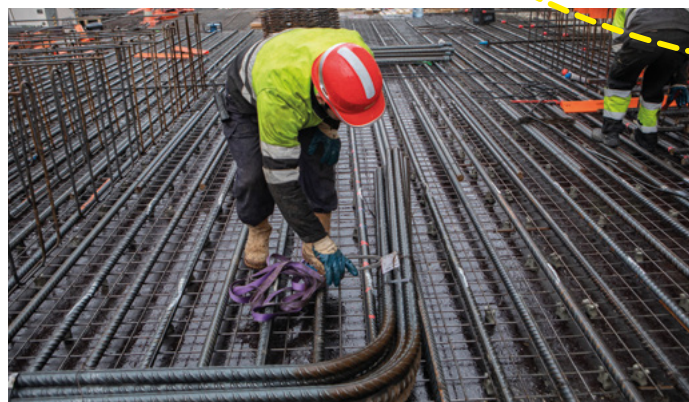
Réalisation de la dalle de couverture de la gare Issy RER.
