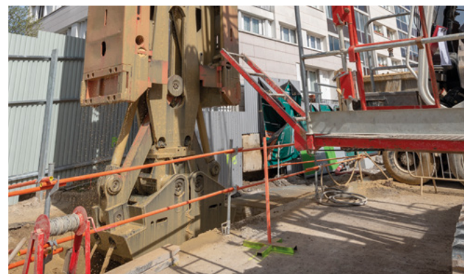
Réalisation des parois moulées de la gare Issy RER.
