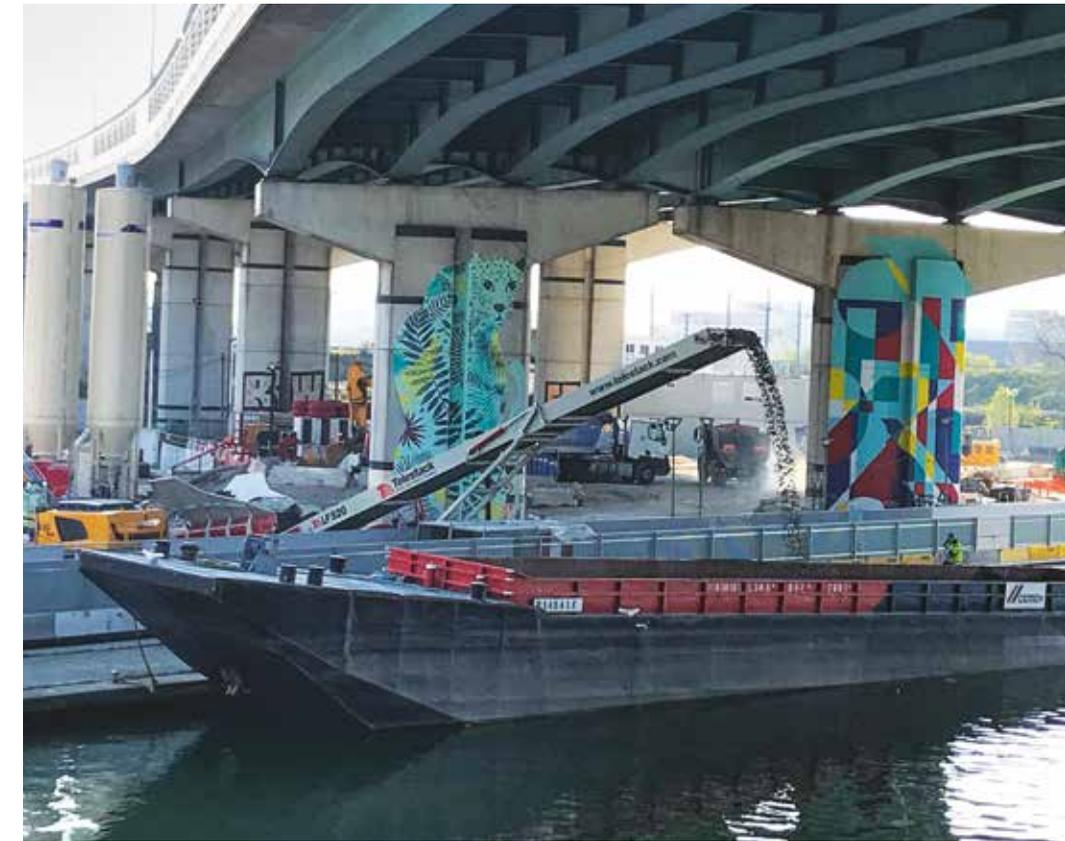
Des plateformes fluviales sont créées pour charger les barges de déblais directement depuis les emprises travaux. La première opération a lieu au printemps sur le chantier de l'ouvrage Puits du Canal, à Aubervilliers. 2019 concrétise le recours au transport alternatif pour évacuer les terres du Grand Paris Express.
