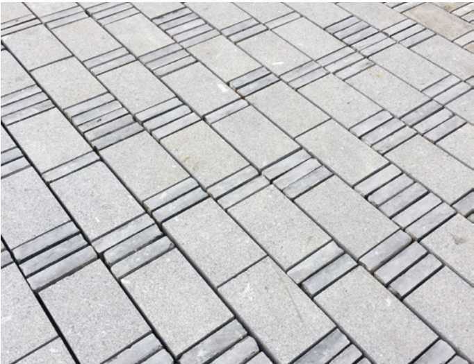
Parvis de Saint-Gilles à Bruxelles : 70 000 pavés de pierre bleue existants sur site sont réemployés, posés sur la tranche et associés à des pavés de granit. (Bureau Bas Smets)
