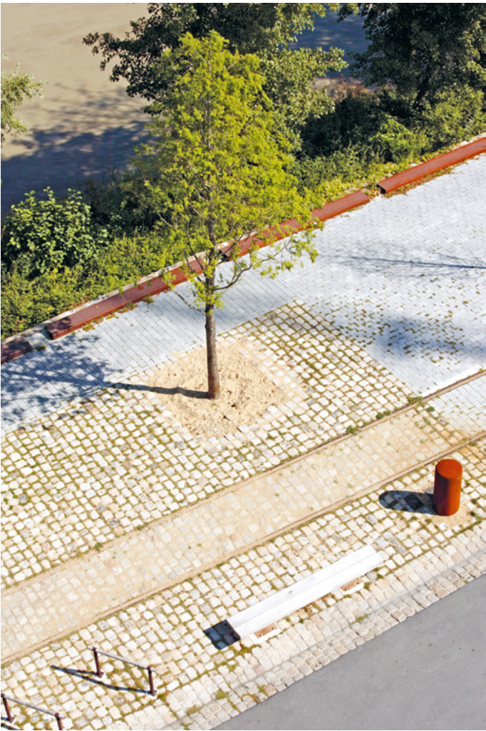
Sur les quais de la Loire de l'Île de Nantes, un sol de pavés réemployés, installés sur des sous-couches de sable, des fosses d'arbres dont la surface reste à découvert, des mobiliers faits d'un assemblage simple d'acier et de bois. Leur disposition laisse les espaces ouverts et accessibles pour l'entretien. (Alexandre Chemetoff & Associés)
