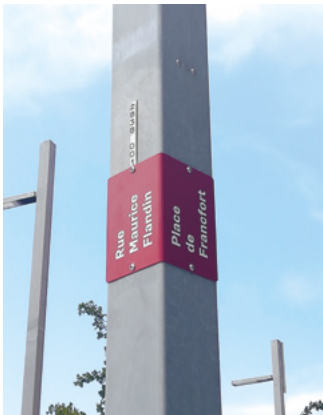
Pour limiter la multiplication des objets dans l'espace public, un mât d'éclairage multifonction dans le quartier de la Part-Dieu à Lyon : en haut, des branchements universels anticipent la connexion d'appareils d'éclairage supplémentaires ; la signalétique prend place à mi-hauteur ; en pied, des services variables sont installés (assises, poubelles, miroirs...). (concepteur lumière : ON)
