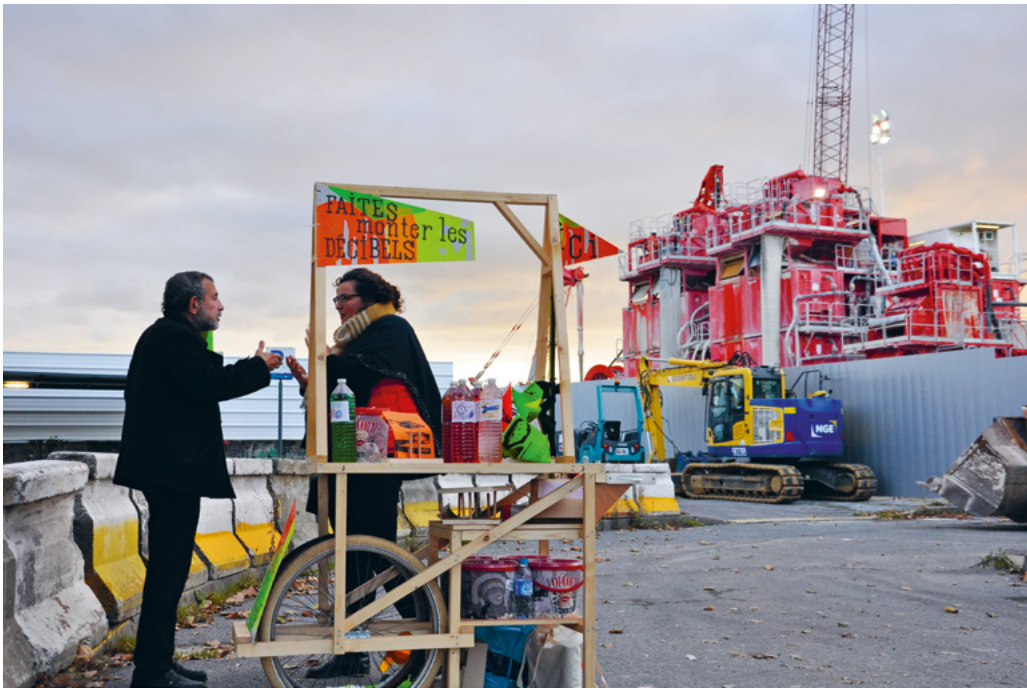
L'accompagnement du chantier de la gare des Ardoines dans le cadre des chantiers partagés de la Société du Grand Paris. (Bruits et Paroles)
