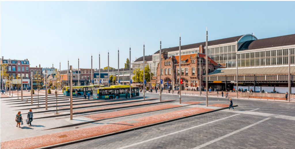
Les espaces publics de la gare de Haarlem aux Pays-Bas intègrent, dans un unique parti d'aménagement, les espaces piétons, la station bus, les lieux de dépose, les espaces d'attente, les stationnements vélos et les espaces de circulation motorisée ou cyclable. Sans traitement continu ni homogène, l'ensemble est unifié par un vocabulaire d'espace public commun. La mise à distance de la gare routière a permis de libérer un espace d'attente et de parcours pour les piétons devant la gare. (wUrck)
