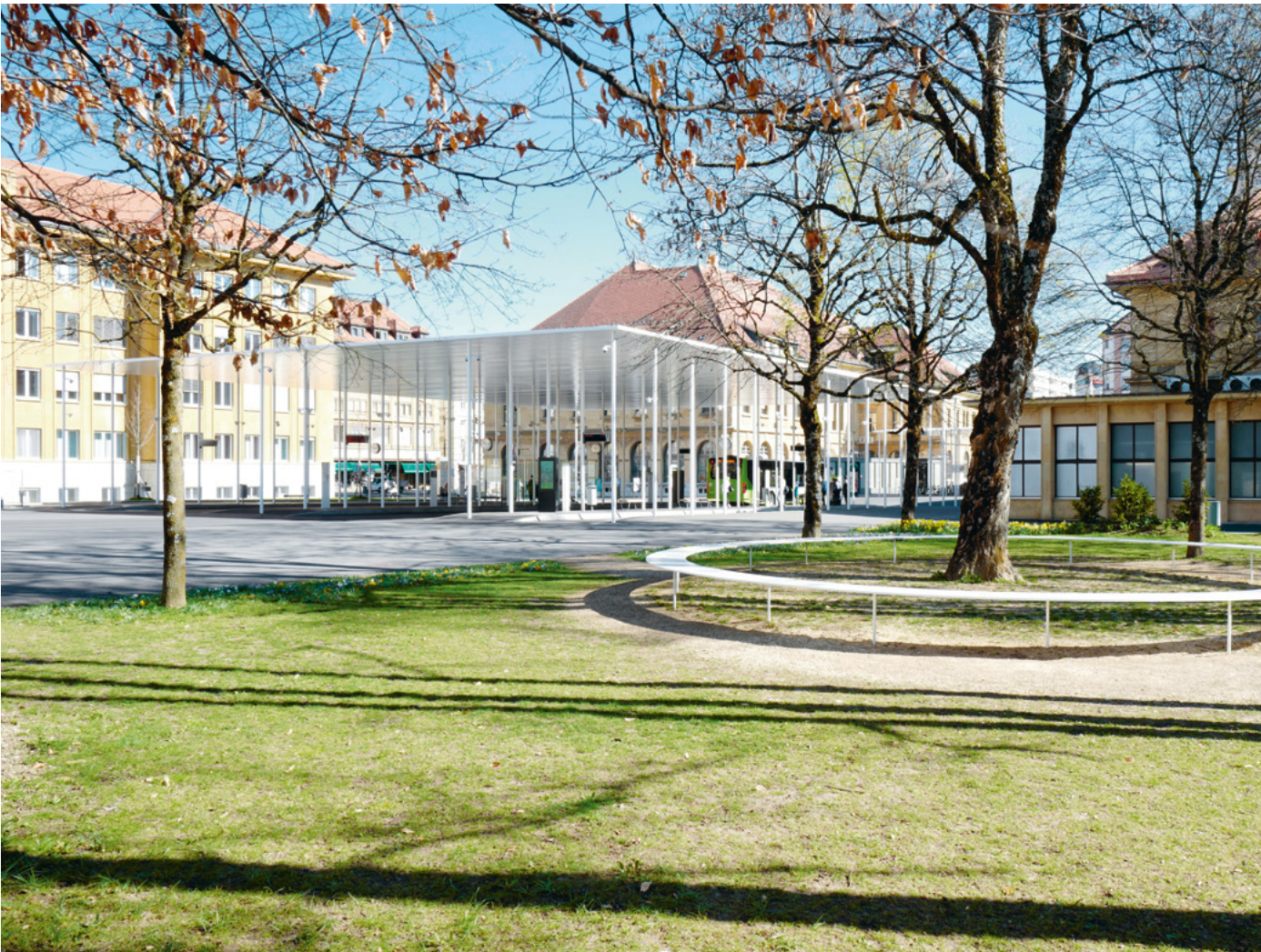
À la gare de la Chaux-de-Fonds, l'attente est présente sous deux formes : un abri ouvert et vaste à proximité des fonctionnalités bus et un espace ombragé et planté en retrait des flux. (Frundgallina)
