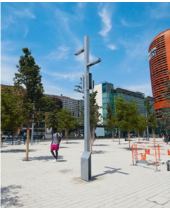
Pour limiter la multiplication des objets dans l'espace public, un mât d'éclairage multifonction dans le quartier de la Part-Dieu à Lyon : en haut, des branchements universels anticipent la connexion d'appareils d'éclairage supplémentaires ; la signalétique prend place à mi-hauteur ; en pied, des services variables sont installés (assises, poubelles, miroirs...). (concepteur lumière : ON)
