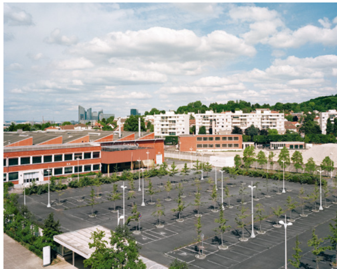
Rueil – Suresnes Mont-Valérien (ligne 15)
