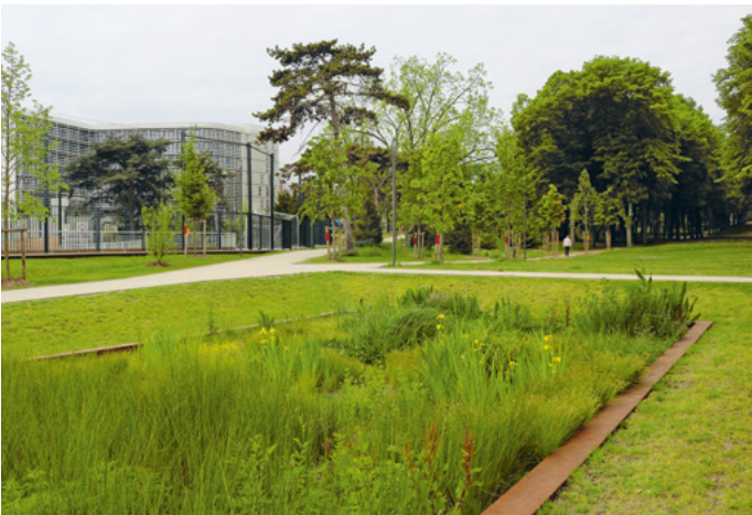
Un jardin en creux à la Cité internationale universitaire de Paris permet d'évapo-transpirer les eaux pluviales et de développer un milieu végétal humide. (TN+)
