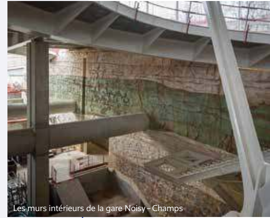
Les murs intérieurs de la gare Noisy – Champs
